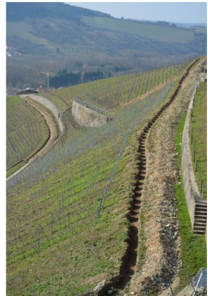
Abbildung 2: Am Thüngersheimer Scharlachberg hat jede Zeile einen Wasseranschluss
