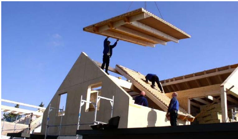
Abbildung 2.3: Dachaufstockung
