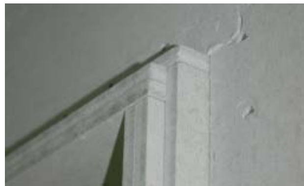
Abbildung 3.3: Stufenfalz in Brandschutzbe- kleidung
