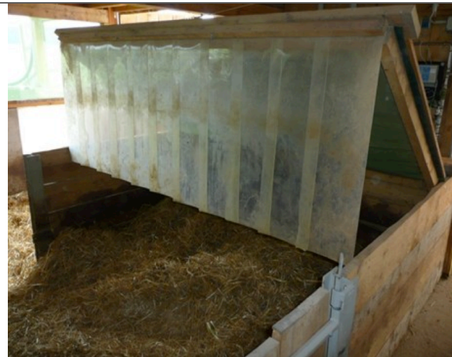
Abbildung 1: Gut schließende Liegekistenabdeckung mit Winkelprofil am Rand
