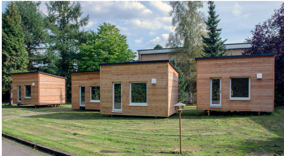
Testhäuser in Holzbauweise zur langfristigen Betrachtung der Innenraumluftqualität. (© Christina Waitkus/Thünen-Institut)
