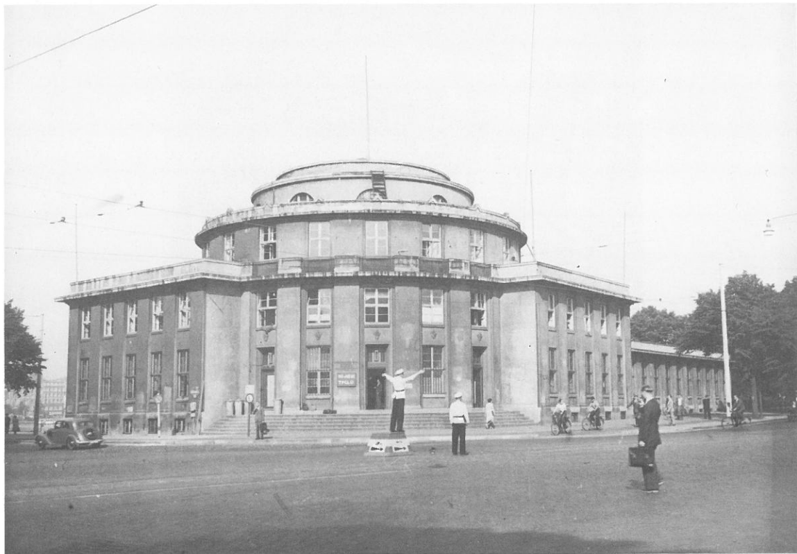
Fig. 3. 1943 to 1945, Bei der Lombardsbrücke 1
