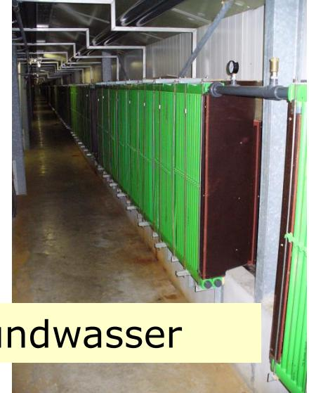
Zuluftkühlung über Erdboden oder Grundwasser
